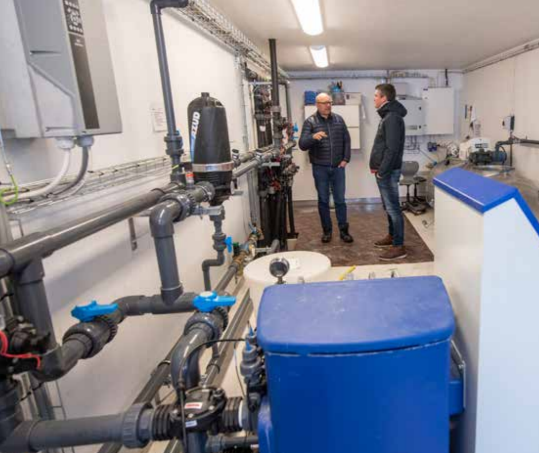
INFRASTRUKTUR: Tunnel dyrking krever betydelig infrastruktur. I «sentralen» blandes gjødselresepter i separate tanker.
