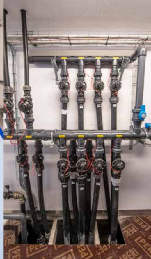
RØROPPLAGG: Det er lagt separate rørgater til ulike tunnelområder som gjør det mulig å skreddersy vanning og gjødsling.
