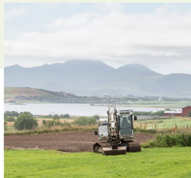
BRUKER GRAVEMASKIN AKTIVT: Leif Kåre bruker grave-maskinen aktivt for å skape mer rasjonelle skifter, samt få mer nedbør til å renne av på overflaten gjennom profilering av myrjord.
